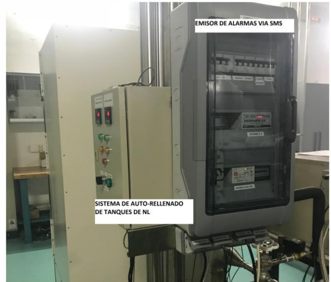
Figura 7.- Área de criopreservación. Se observan el sistema de auto-rellenado de los tanques de NL en caso de bajada de los niveles del mismo y el sistema de alarmas SMS de detección de niveles bajos de NL.
