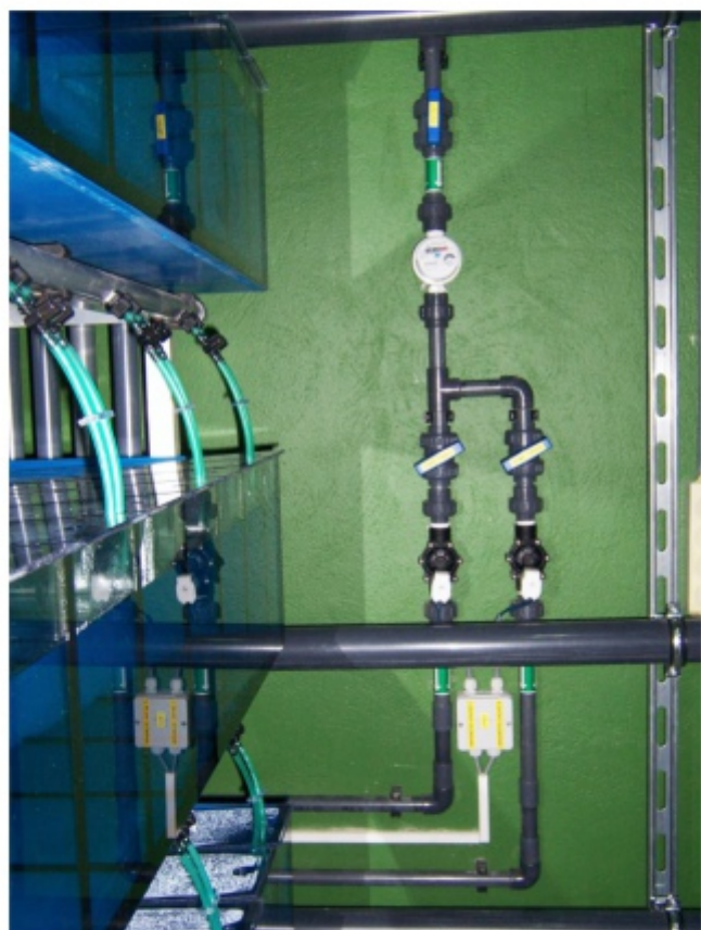
Figura 6.- Llaves de paso y contadores de control de agua.
