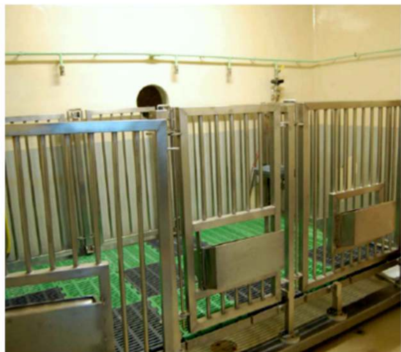
Figura 1.- Estructuras de acero inoxidable desmontables para porcino y elevadas del suelo para facilitar el lavado y la eliminación de deyecciones y orina. Instalaciones del INIA-CISA.
