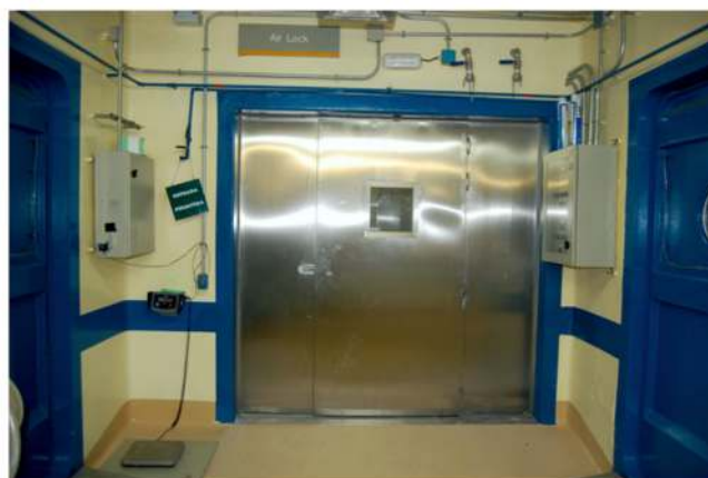
Figura 5.- Sterile Air System (S.A.S) biológico de gran tamaño y cercano a las habitaciones para el paso de animales. Instalaciones del INIA-CISA.
