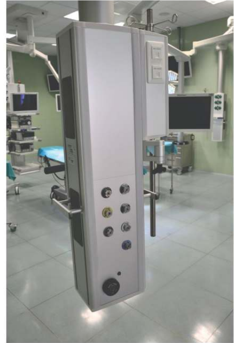
Figura 3.- Brazo telescópico móvil con conexiones de gases medicinales, vacío y extracción de gases anestésicos.
