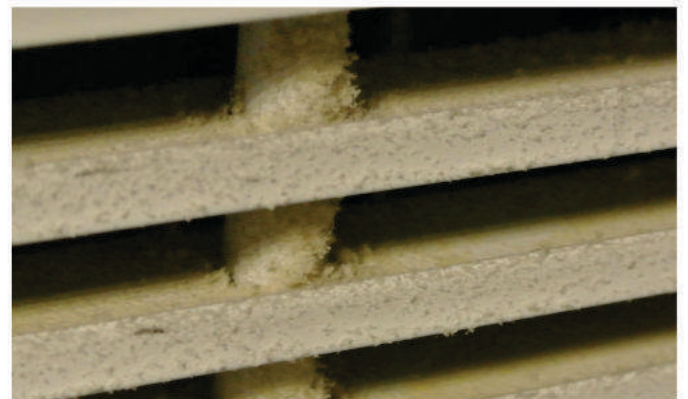
Figura 1.- Polvo aglutinante en una rejilla de extracción. Este tipo de polvo está formado por partículas aglutinantes finas, sustancias húmedas y materiales fibrosos.
