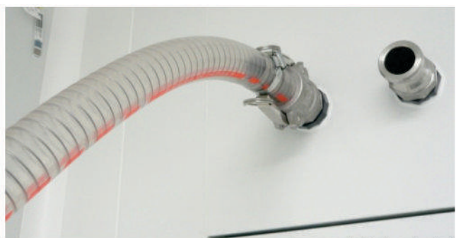
Figura 2.- Separación de la impulsión y extracción dentro de la sala mediante una manguera flexible.
