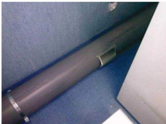
Figura 10.- Extracción a nivel del suelo.
