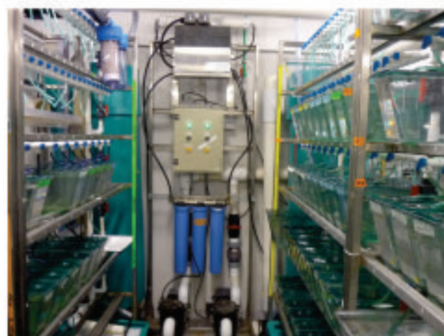
Figura 3.- Sistema de impulsión. El proceso de ósmosis genera agua de una alta calidad eliminando los sólidos de la misma.
