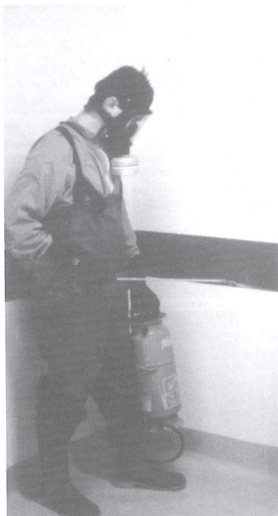
Foto 7: Descontaminando pared
